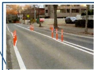
ラバーボールの設置
