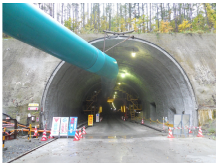
富良野道路北の峰トンネル坑口（武田撮影）
